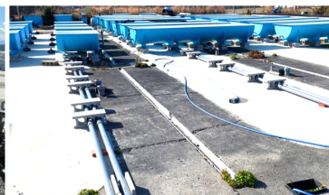
搬入した水槽と整備中の送水配管
