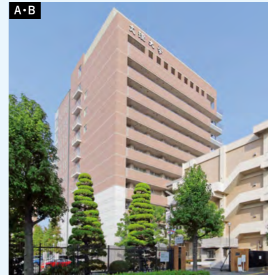
薬学部 実験・研究棟
