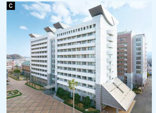
管理棟・人間生活学部研究棟
