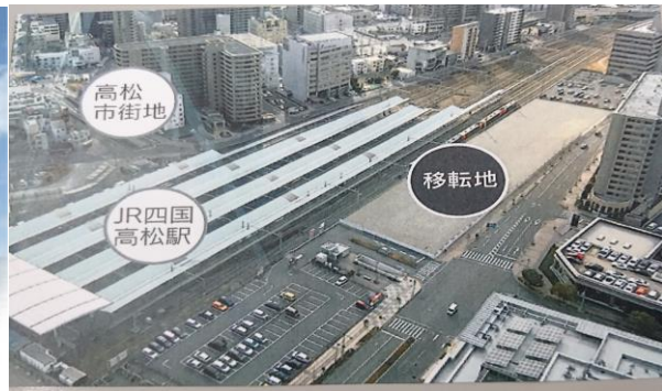
【高松市浜ノ町 高松駅キャンパス建設地】
